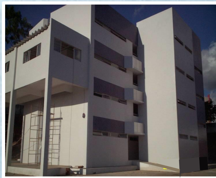
FASE FINAL – FACHADA POSTERIOR E PASSARELA
