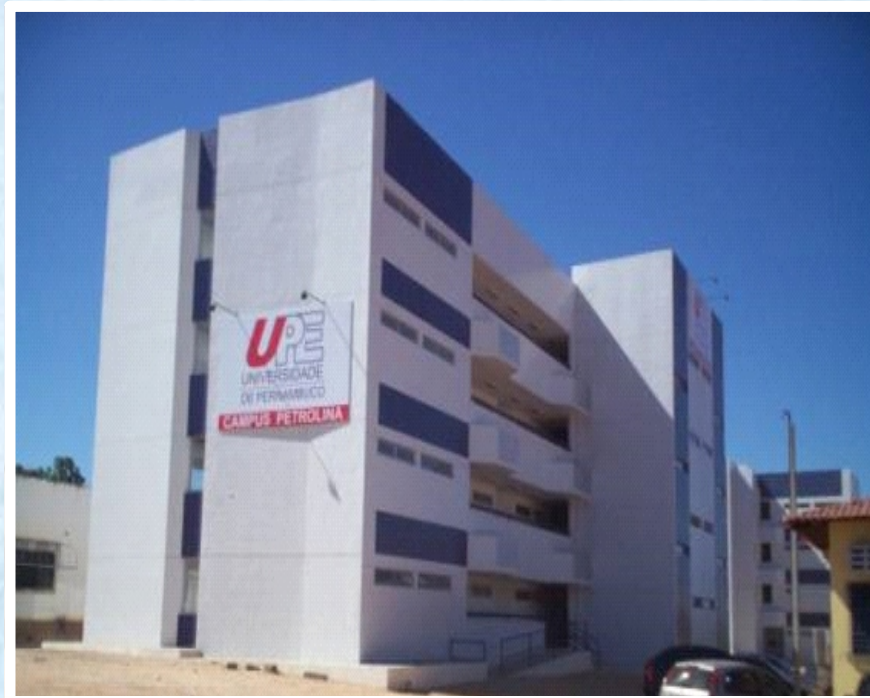
FASE FINAL - FACHADAS
