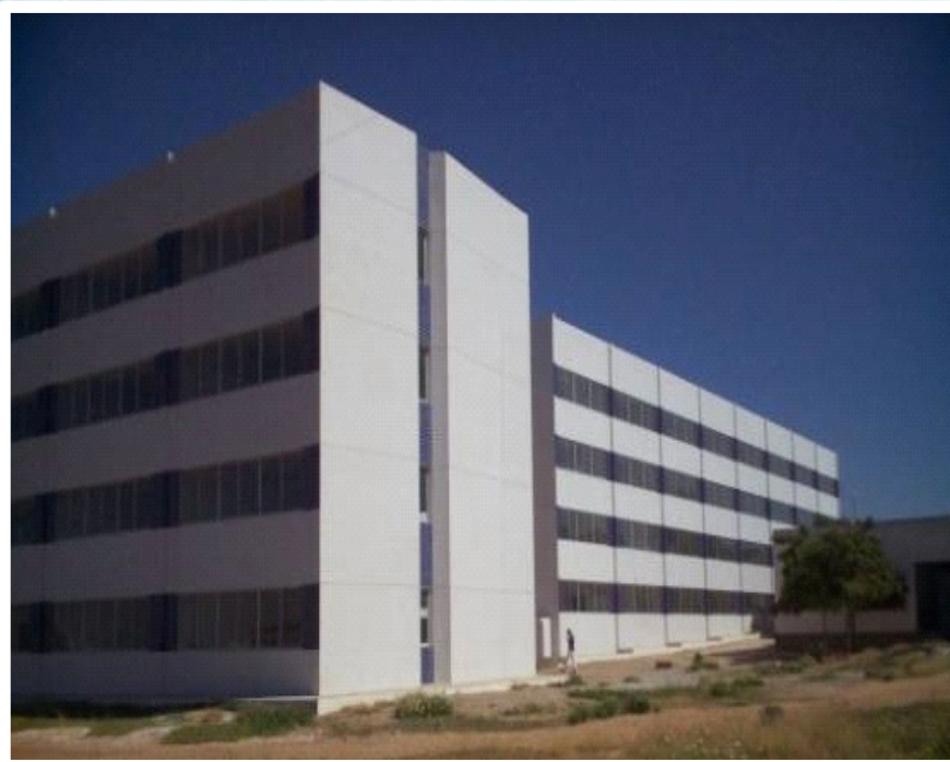
FASE FINAL - FACHADAS DOS BLOCOS
